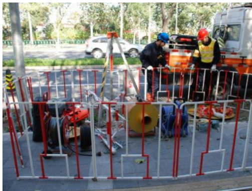
图 4-2 作业现场围挡
